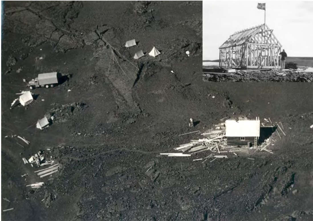
Flugmynd af skálanum í Jökulheimum í byggingu í júní 1955. Ljós- óþekktur. Innfellda myndin er tekin nokkrum dögum fyrr. Ljós-:Photo. Árni Kjartansson. – The hut in Jökulheimar by the western edge of Vatnajökull in construction in June 1955.
